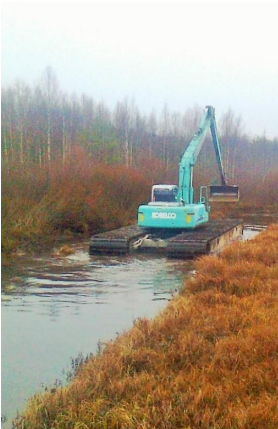
Kuva 5: Kelluva ruoppaaja matkalla kohti purettavaa turvelauttaa 9.11 (kuva ely-keskus/Pitkäjärvi)
